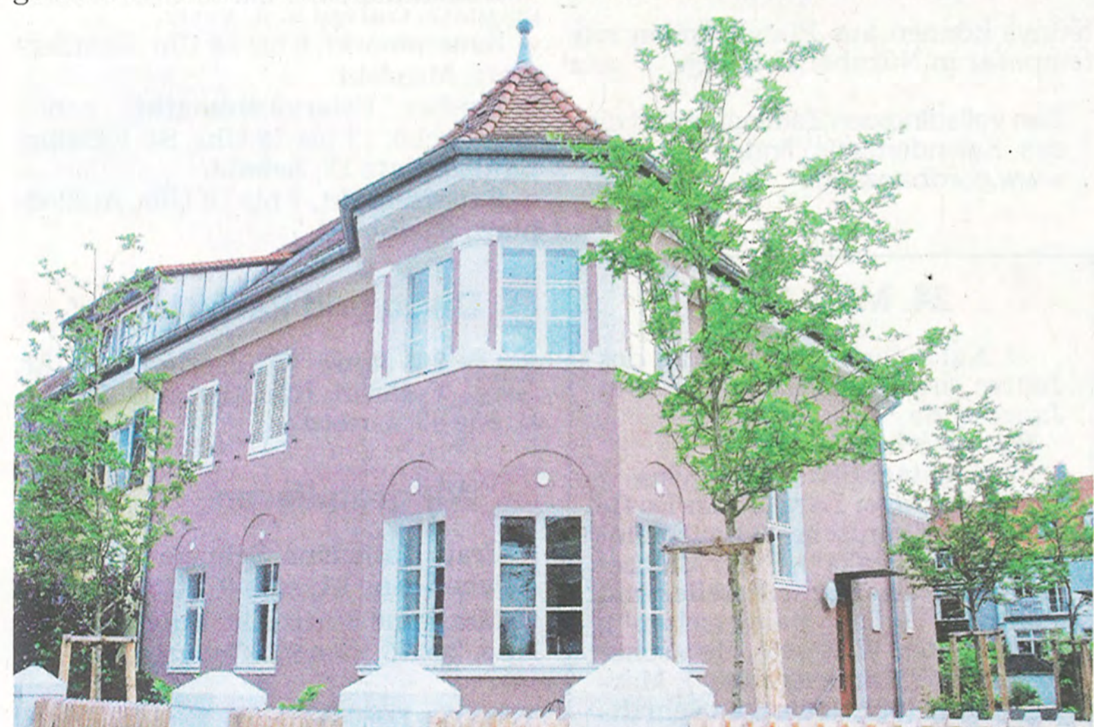
Die Farbe ist original: das Eckhaus Danziger Straße 8.
