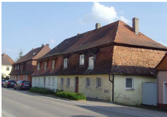
Häuserzeile Neunstetter Straße 11 -17 (Foto Arch.büro)
